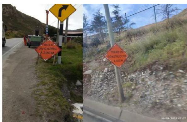
Panel Fotográfico 2. Señales preventivas ubicadas en las zonas intervenidas, las cuales permanecen hasta la extensión de la mezcla asfáltica.
