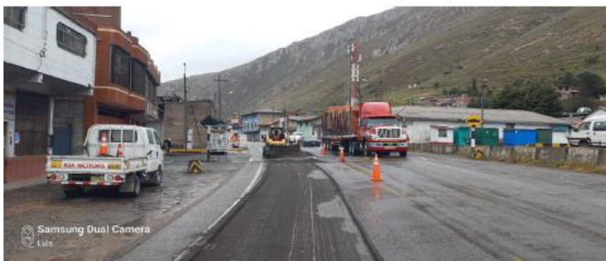
Panel Fotográfico 1. Actividades de fresado de la carpeta asfáltica
