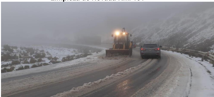
Limpieza de Nevada Km. 131
