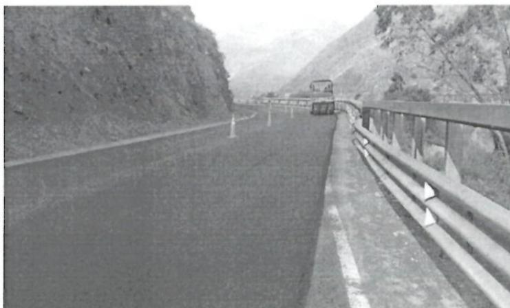
Foto 1: Km 70 al Km 71 Colocación y compactación de capa nivelante. (06.09.2017)
