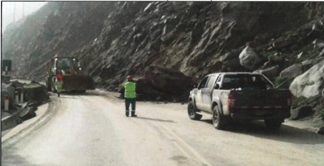
Nota: Trabajos de Operarios y Maquinaria para retiro de roca de gran magnitud, además de la señalización en el campo
