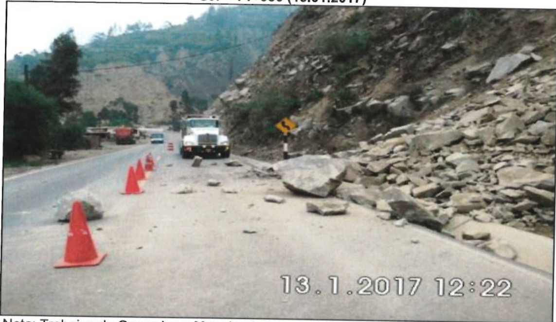
Nota: Trabajos de Operarios y Maquinaria para retiro de roca de gran magnitud, además de la señalización en el campo
