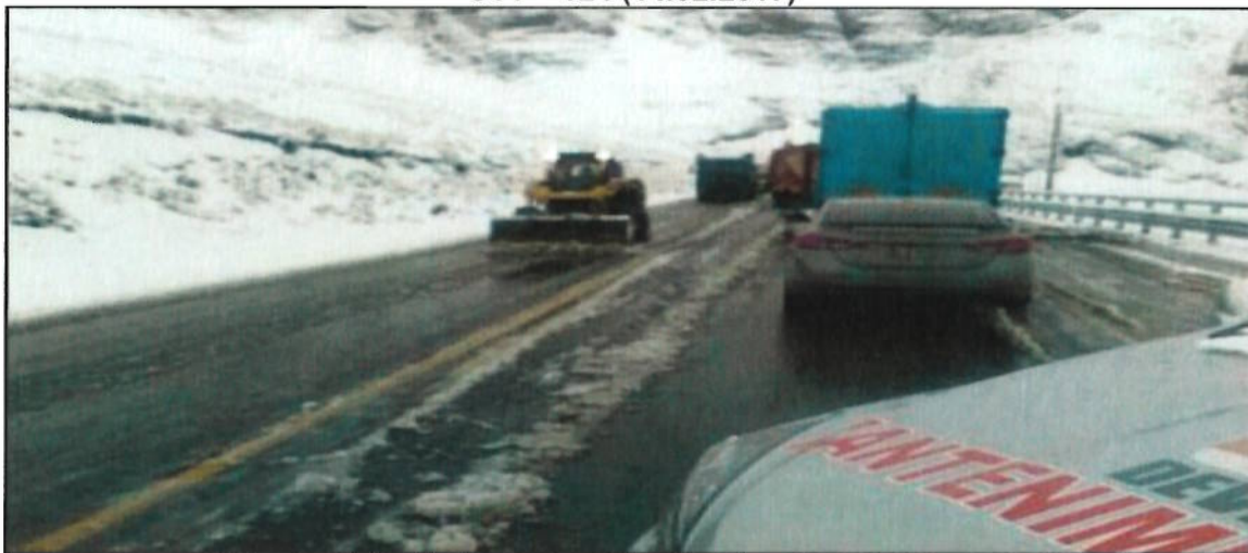
Nota: Trabajo de Operario y Maquinaria retirando la nevada.
