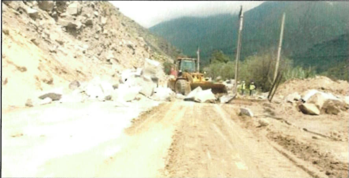
Nota: Trabajo de Operarios y maquinarias para la limpieza de la vía, además de señalización.
